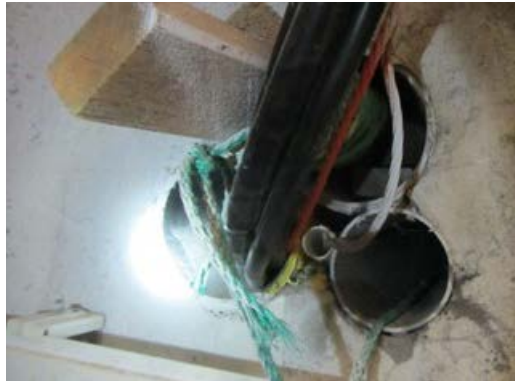
Kuvat 21 ja 22. Rakennuksen kellarin maanvastaiseen seinärakenteeseen vaikuttaa maaperäkosteus ja rakenteessa on tiivistämättömiä läpivientejä.
