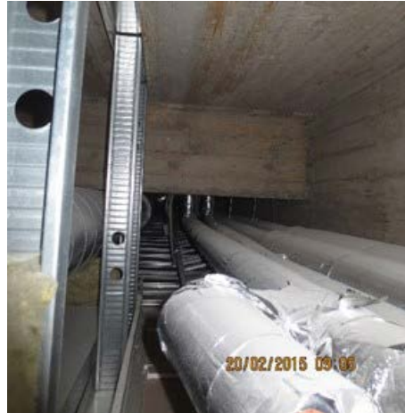
Kuvat 19 ja 20. Uusia ja vanhoja tiivistämättömiä talotekniikan putkia ja niiden läpivientejä vanhassa putkikanaalissa. Alaslaskettujen kattojen asennustilassa oli runsaasti rakennusaikaista pölyä.
