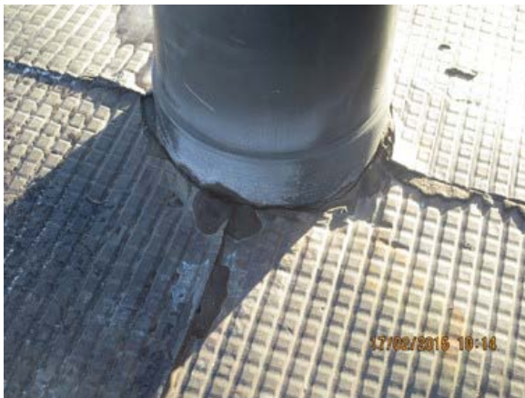
Kuvat 16 ja 17. Pintakermin saumauksissa havaittiin hammastusta ja liimauksen irtoamista.
