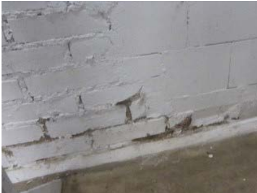
Kuvat 21 ja 22. Rakennuksen kellarin maanvastaiseen seinärakenteeseen vaikuttaa maaperäkosteus ja rakenteessa on tiivistämättömiä läpivientejä.
