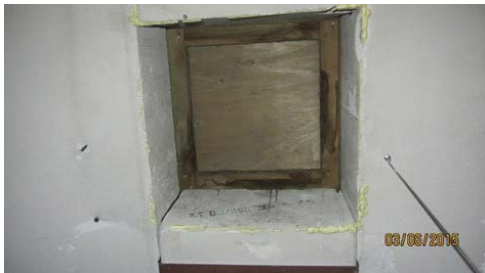
Kuvat 12 ja 13. Käytävän yläpohjarakenteessa on tiivistämätön läpivienti yläpohjaonteloon. Maanvastaisen seinän ja maanvaraisen lattiarakenteen rakenneliitoksessa olevassa tiivistyksessä oli epätiiviyyskohtia.
