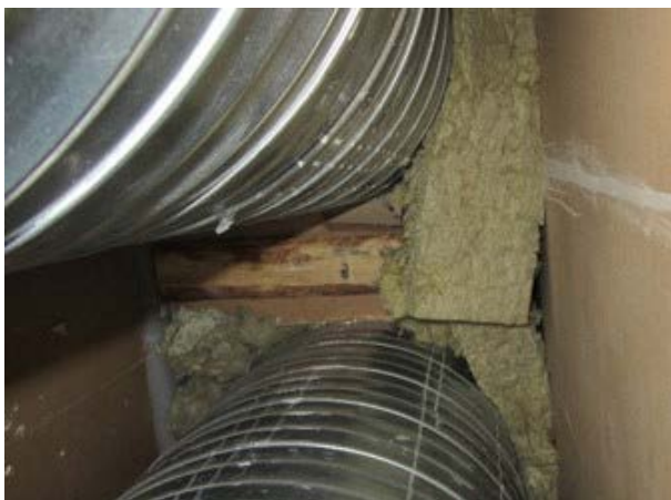
Kuvat 10 ja 11. Talotekniikkakanaalissa olevien putkien läpiviennit rakenteiden läpi eivät ole tiiviitä ja kanaalista tuli vuotoilmaa kanaalin tarkastusluukun liitoksien kautta opetustilaan.
