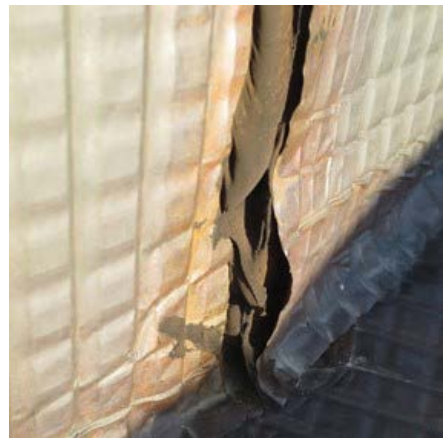
Kuvat 16 ja 17. Pintakermin saumauksissa havaittiin hammastusta ja liimauksen irtoamista.
