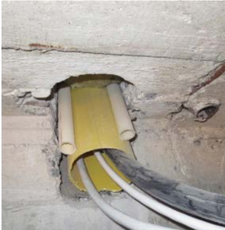
Kuvat 19 ja 20. Uusia ja vanhoja tiivistämättömiä talotekniikan putkia ja niiden läpivientejä vanhassa putkikanaalissa. Alaslaskettujen kattojen asennustilassa oli runsaasti rakennusaikaista pölyä.
