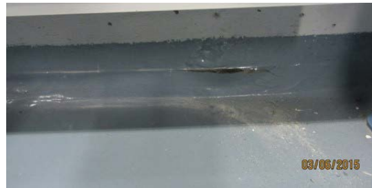
Kuvat 12 ja 13. Käytävän yläpohjarakenteessa on tiivistämätön läpivienti yläpohjaonteloon. Maanvastaisen seinän ja maanvaraisen lattiarakenteen rakenneliitoksessa olevassa tiivistyksessä oli epätiiviyyskohtia.
