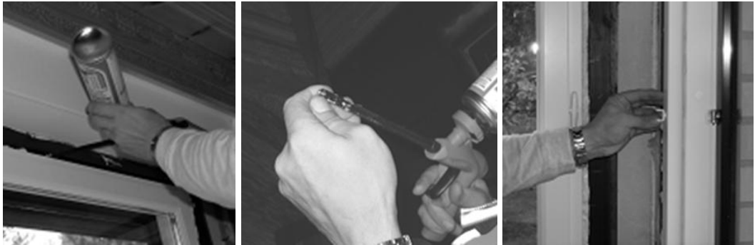
Kuvat 9-11: Työvaiheita ikkunoiden tiivistämisessä
