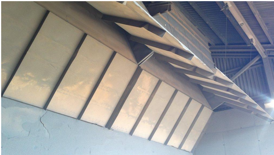
Kuva 12. Uusitun kohdepoiston imuaukko ja kaulukset. Oviaukon puoleiset kaulukset ovat nostettavissa ylös kappaleiden sisääntuonnin ja poisviennin ajaksi.
