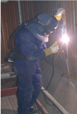
Kuva 1. Huolto- ja korjaustyöt kattilalaitteiden sisällä.
