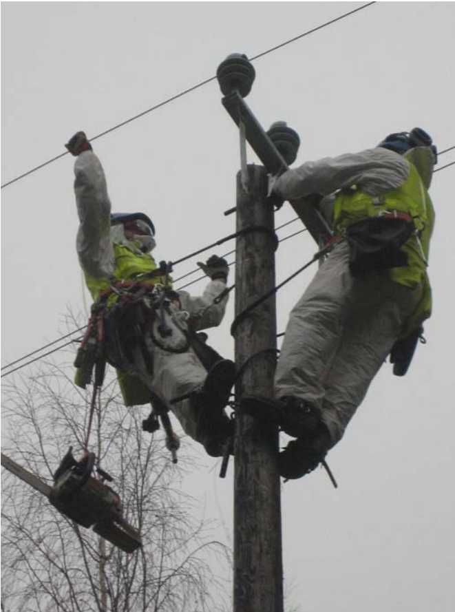
Kuva 8. Suojautuminen pylväitä sahattaessa tai porattaessa.
