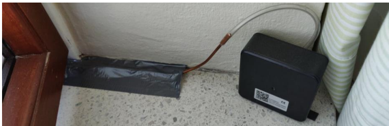
Kuva 3. Mittauskohteen ulkovaipan paine-eron mittaus sisätilan ja ulkoilman välillä ikkunakarmin kohdalta.
