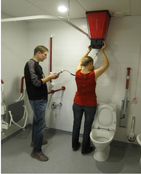
Kuva 4.3. Poistoilmavirran mittaaminen eristystilan WC-tilassa balometrilla.
