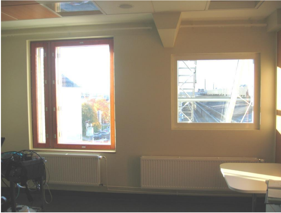
Kuva 6.13. Eristystila, jossa on kaksi ikkunaa. Toisessa on avattava tuuletusikkuna.
