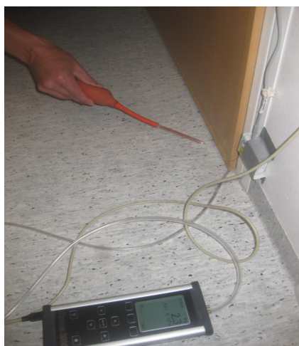
Kuva 4.2. Paine-eron mittaus ja vuotokohtien havainnointi savulla.
