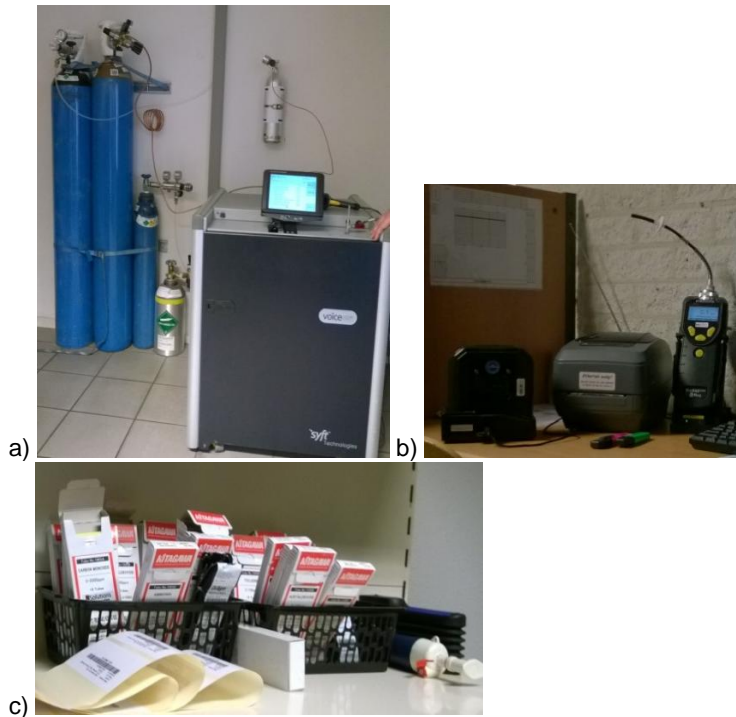
Kuvat 2 a–c. a) EWS:n terminaalin laboratorioon kiinteästi asennettu Syft-MS-analysaattori tarvittavien kaasupullojen kanssa, b) käsikäyttöisiä mittareita happipitoisuuden ja LEL-pitoisuuden mittaamiseen, c) analyysiputkia.
