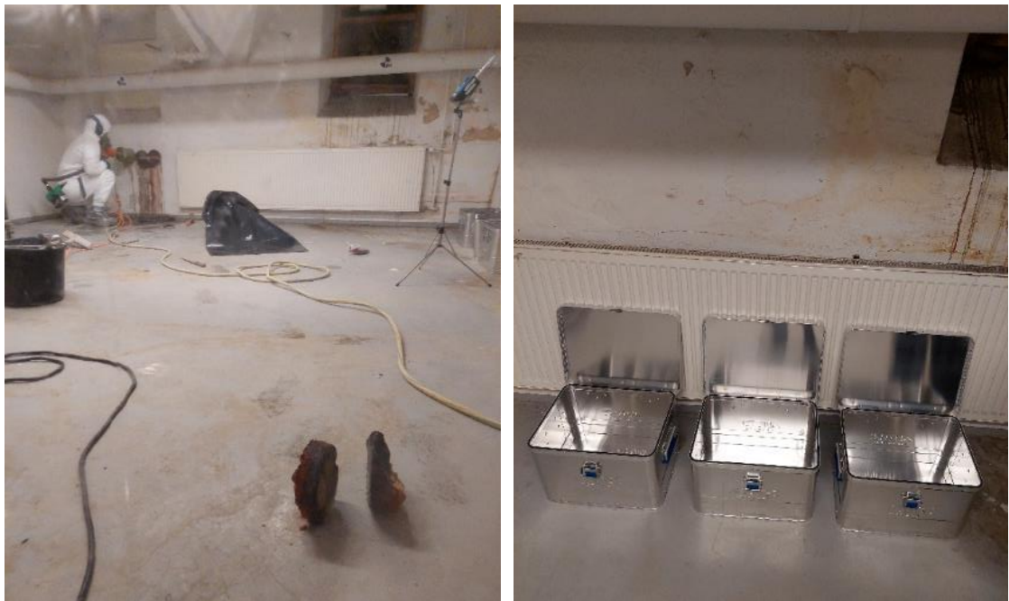
Kuva 16. Näyteliieriöiden irrotus tehtiin osastossa. Näyteliieriöt pakattiin ilmatiiviisiin metalliastioihin.
