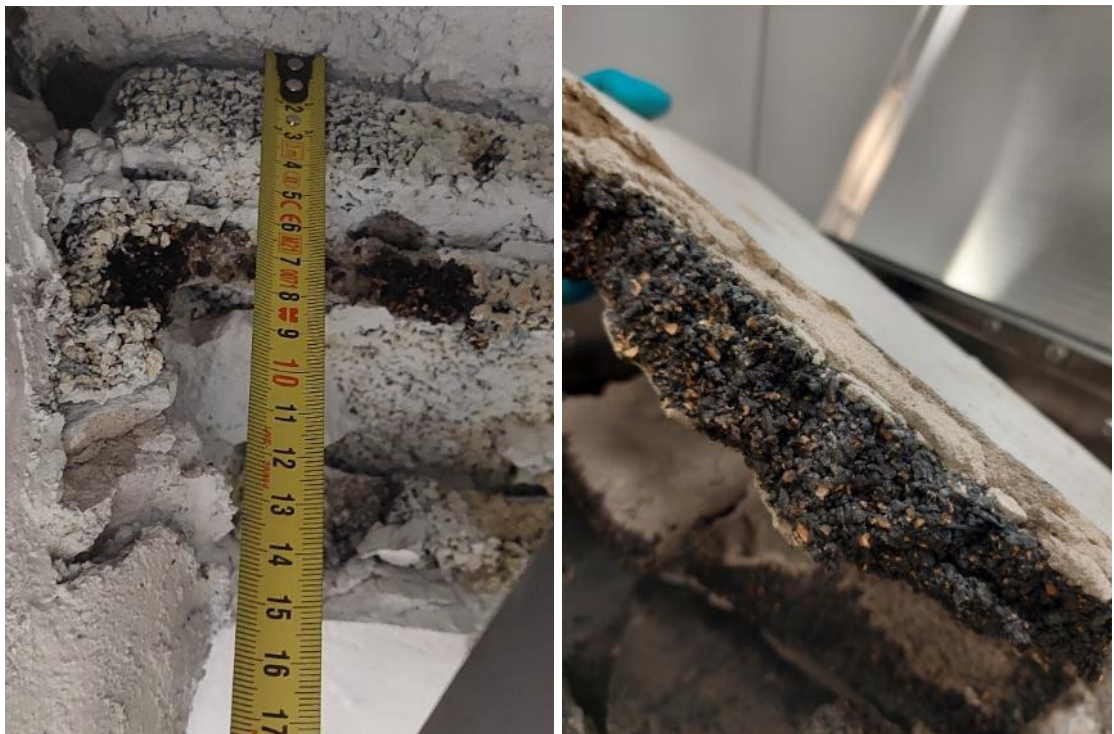
Kuva 28. Vasemmalla: Korkkilevyä oli kattopinnalla useita kerroksia. Korkkilevyn palat pakattiin metallilaatikoihin ja säilytettiin viileässä.
