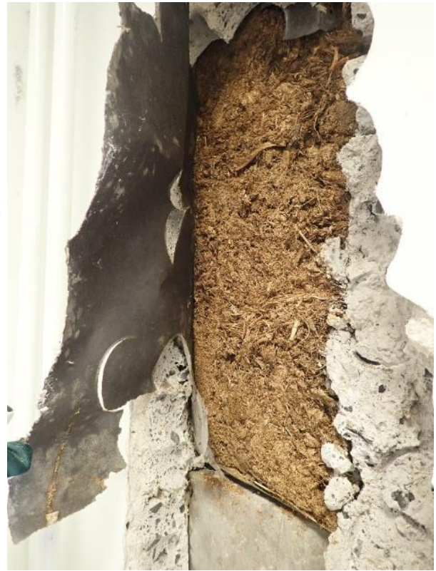
Kuva 21. Tutkitun ulkoseinärakenteen periaateleikkaus ja tervapaperilla vuorattujen harkkojen asennusperiaate.
