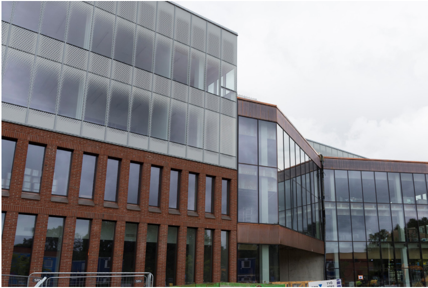
Kuva 2: BIZ:n uudet Otaniemen toimitilat rakenteilla
