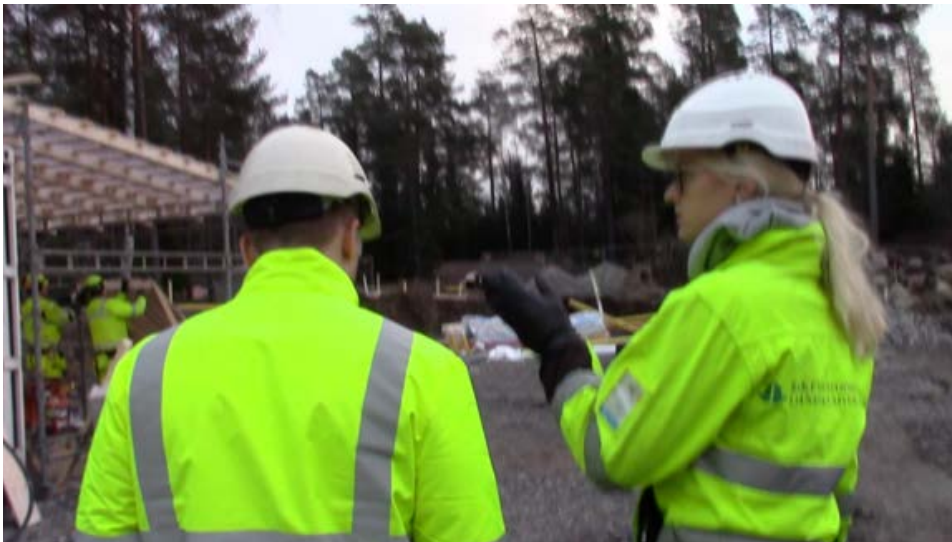
Kuva 4.4. Työmaakierros on oleellinen osa työmaahan perehdyttämisestä.
