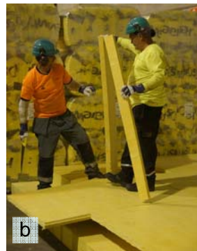
Kuva 5. a) Työpari asentaa lamelliratkaisun päällysvillaa. OL-LAM asennus on jo saavuttanut riittävän n. 5 m. rajan. b) Työpari viimeistelee perinteisen villaratkaisun asennusta. Tutkimuksessa asennuksen etureunan ei tarvinnut olla tasainen, kunhan 5 m etenemä tuli saavutettua.
