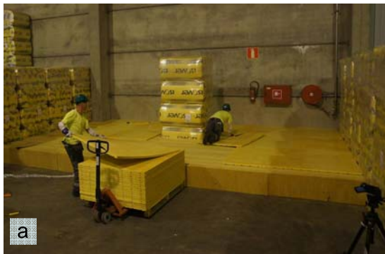
Kuva 5. a) Työpari asentaa lamelliratkaisun päällysvillaa. OL-LAM asennus on jo saavuttanut riittävän n. 5 m. rajan. b) Työpari viimeistelee perinteisen villaratkaisun asennusta. Tutkimuksessa asennuksen etureunan ei tarvinnut olla tasainen, kunhan 5 m etenemä tuli saavutettua.
