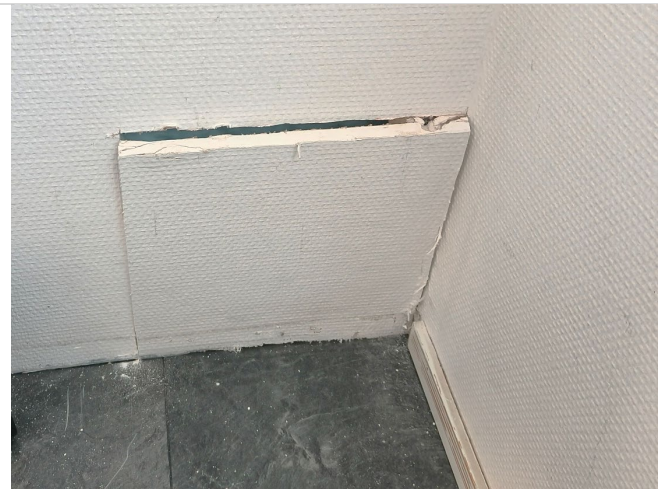
Kuva 9. Väliseinä, jossa ei kuntoarviomenetelmin havaittu viitteitä vauriosta.
