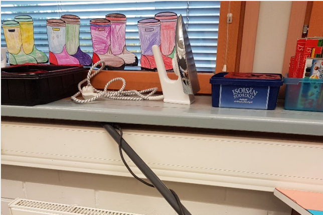
Kuva 60. Ikkunaliitoksen ilmavuototarkastelu merkkiainetutkimuksella.
