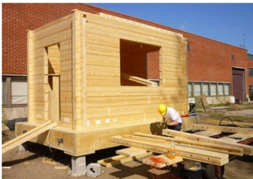
Kuva 9. Hirsistä rakennettu koerakennus pystytysvaiheessa (Winter et al. 2012).
