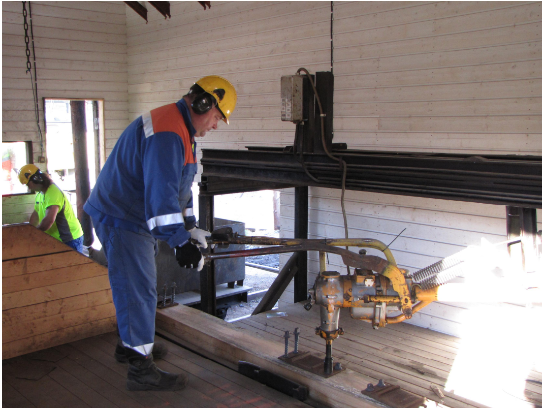
Kuva 10. Aluslevyjen asennusta ratapölkkyihin.
