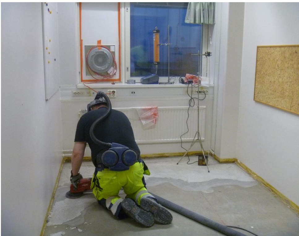
Kuva 6. Sairaalan 1 mittaukset. Ikkunan vieressä hiukkasmittalaitteet.
