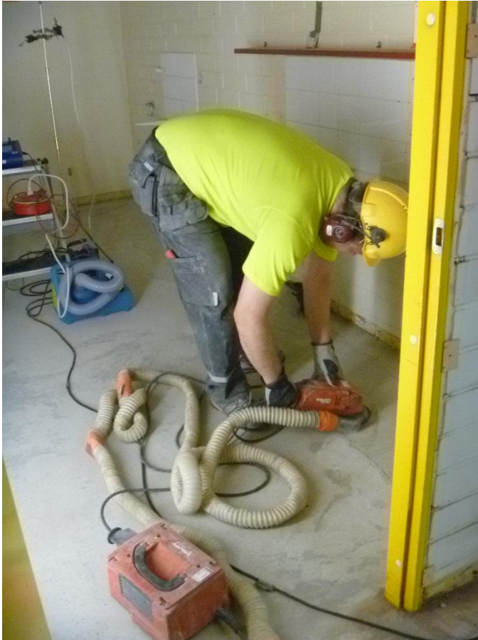
Kuva 11. Lattian hiontaa yliopistokohteessa.
