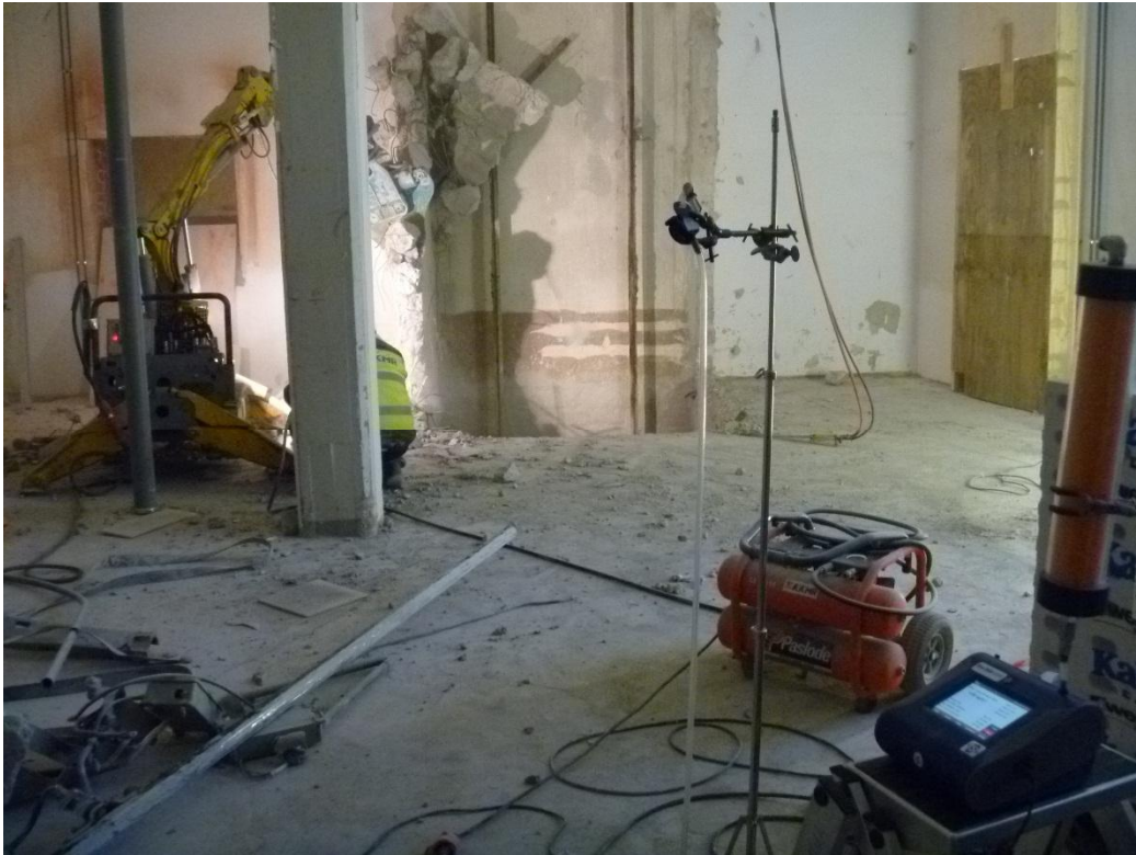
Kuva 3. Hissikuilun purkua (mittaus 1) purkurobotilla kerrostalokohteessa. Kuvan oikeassa alareunassa hiukkasmittalaitteet.
