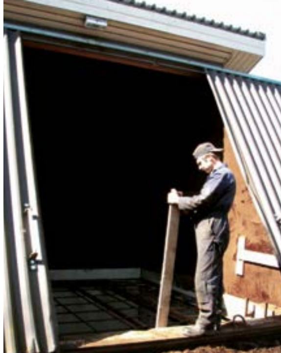
Kuva 8. Holvaantunutta polttoainetta voi purkaa esimerkiksi tällä tavalla (YTOT 1/09).
