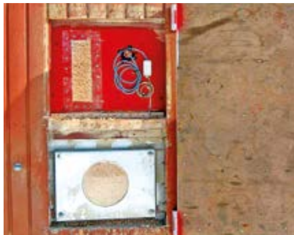
Kuva 5. Tapaturman jälkeen pelastustyön aikana tehtyyn aukkoon rakennettiin siilon huoltoluukku sekä ikkuna pelletin määrän tarkkailuun. Lisäksi asennettu pintavahti (johdot) (YTOT 2/08).
