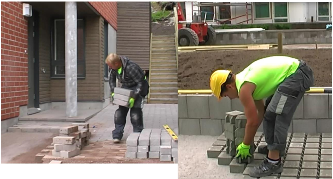
Kuva 20. Kivien asennustyöhön liittyy kivien käsin kantamista. Vasemmanpuoleisessa kuvassa enimmäisnostotaakkasuositus on 18,4 kg noston alussa ja lopussa. Oikeanpuoleisessa kuvassa enimmäisnostotaakkasuositus on 19,5 kg noston alussa ja 18,4 kg noston lopussa.
