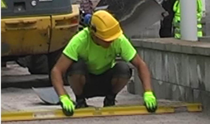
Kuva 19. Alustan tasaamisessa esiintyy selkää kuormittavaa kumarassa työskentelyä ja samanaikaisesti molemmat polvet ovat koukussa.
