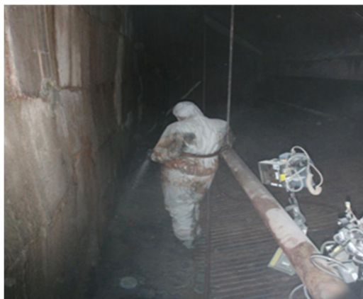
Kuva 14. Tulikynnys, kattilan sisäosan pesu.
