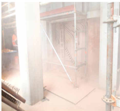
Kuva 13. Kattilasalin seinän purku.
