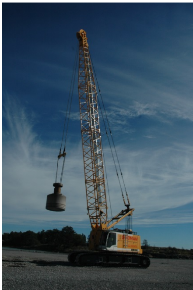
Kuva 5. Syvätiivistys. Kuva: (Sjöman Helsingin Nosturit Oy, 2013)
