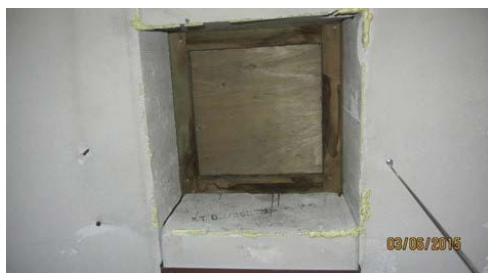
Kuvat 12 ja 13. Käytävän yläpohjarakenteessa on tiivistämätön läpivienti yläpohjaonteloon. Maanvastaisen seinän ja maanvaraisen lattiarakenteen rakenneliitoksessa olevassa tiivistyksessä oli epätiiviyyskohtia.
