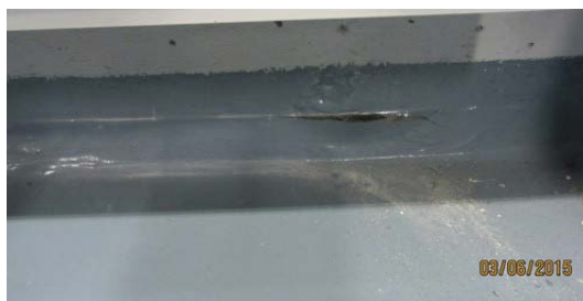
Kuvat 12 ja 13. Käytävän yläpohjarakenteessa on tiivistämätön läpivienti yläpohjaonteloon. Maanvastaisen seinän ja maanvaraisen lattiarakenteen rakenneliitoksessa olevassa tiivistyksessä oli epätiiviyyskohtia.
