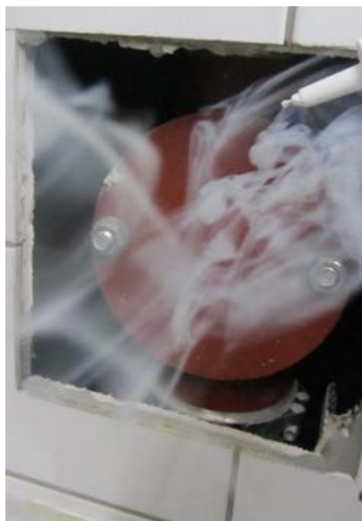
Kuvat 10 ja 11. Talotekniikkakanaalissa olevien putkien läpiviennit rakenteiden läpi eivät ole tiiviitä ja kanaalista tuli vuotoilmaa kanaalin tarkastusluukun liitoksien kautta opetustilaan.
